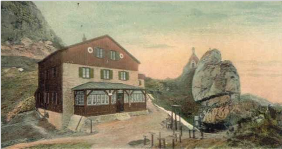
1883 wurde die meteorologische Hochstation II. Ordnung mit Wetterhütte und Regenmesser vor dem Wendelsteinhaus errichtet.
